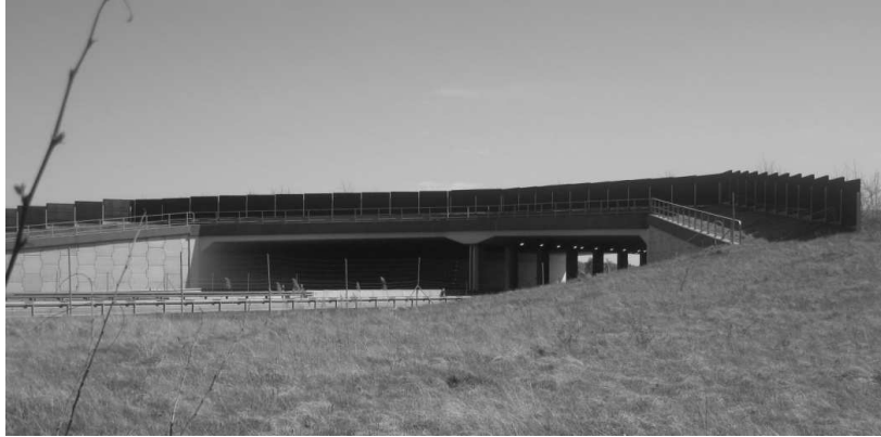
RYSUNEK 4. Przejście górne dla dużych zwierząt na odcinku Białobrzegi – Jedlińsk FIGURE 4. Ecological passage for large animal on the Białobrzegi – Jedlińsk part
