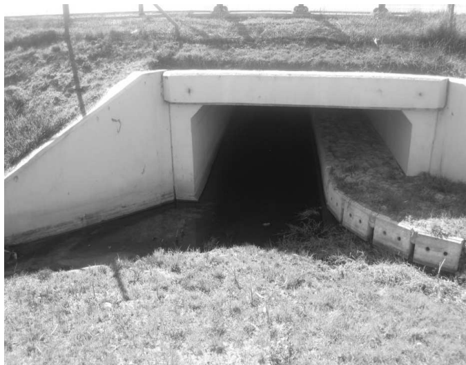
RYSUNEK 3. Przepust ekologiczne pełniący funkcję przejścia dla średnich zwierząt na odcinku Białobrzegi – Jedlińsk
